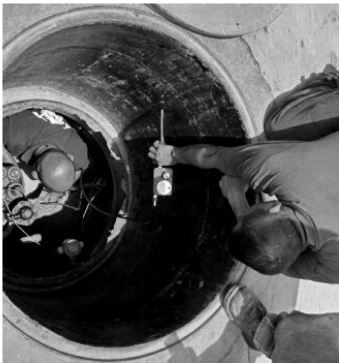
Comprobación ATEX en un pozo de gasolinera.
